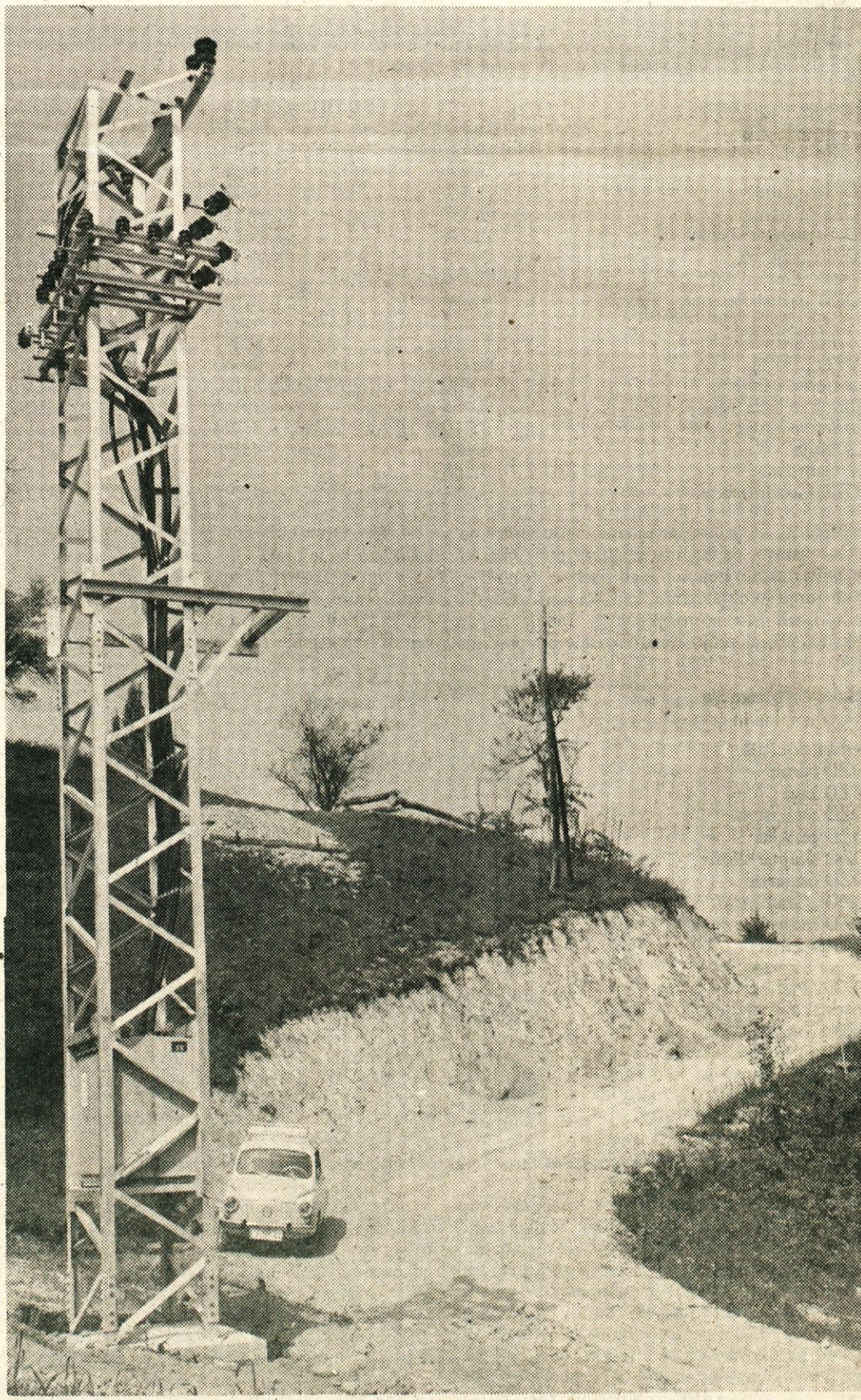
Gradnja nove ceste na Veliki vrh in novega el. omrežja lepo napreduje. Tamkajšnji občani so v akciji sodelovali z ogromnim številom prostovoljnih delovnih ur in s prispevki v denarju.
