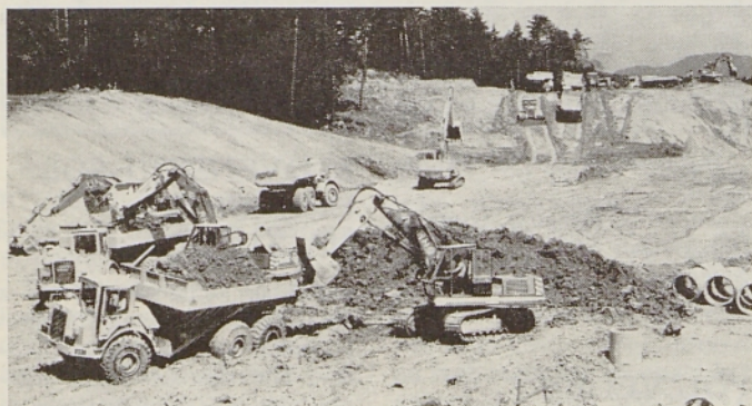
Zemeljska dela na zahodni obvoznici Ljubljane (Brezovica–Šiška).
