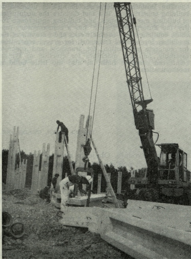
Sl. 7. Montaža stebrov tipske hale z bagrom
