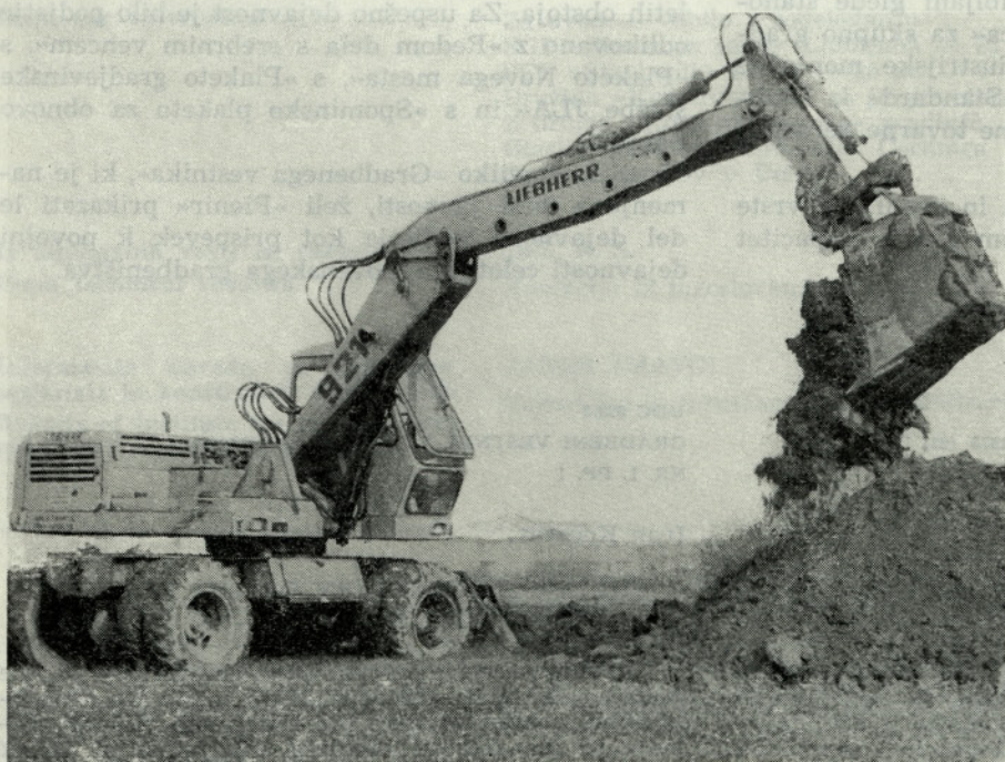
Sl. 1. Izkop z večjim bagrom znamke Liebherr 921
