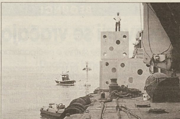
Zgoraj desno in ob strani, potek postavitve bodočega ribjega »doma«, nedaleč od Sv. Križa. Koncesija je bila podeljena Fipsasu iz Trsta
