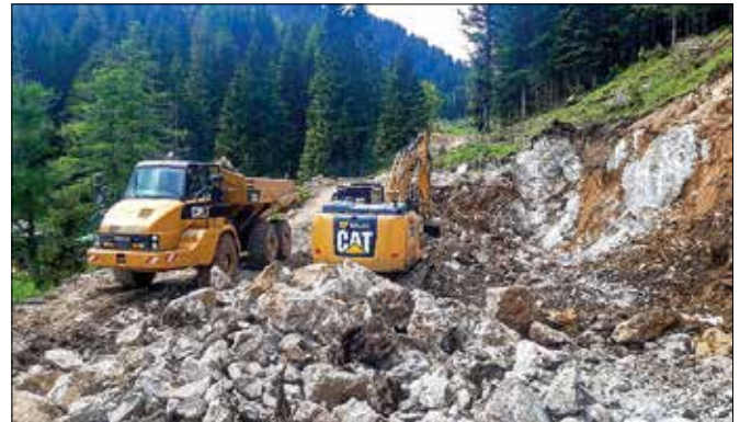
Franc Brlec je s svojo ekipo zgradil novo povezovalno cesto od Alpskega vrta do gradbišča nove Mozirske koče.
