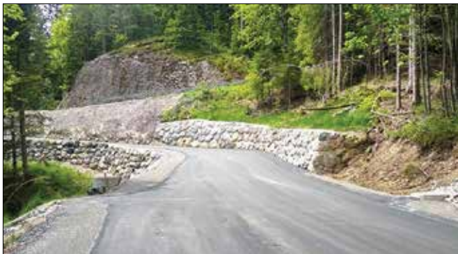
Geotehnično zelo zahtevna sanacija odseka Solčavske panoramske ceste je pred pričetkom poletne turistične sezone končana.
