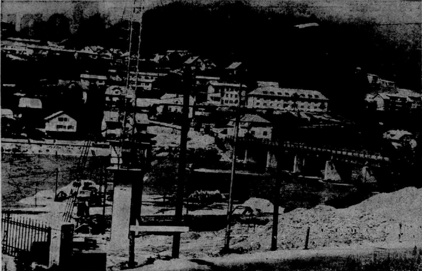
NOVI MOST ČEZ DRAVO — Blizu starega dravogradskega mostu, ki ga je še davno močno oglodal zob časa, že nekaj tednov gradijo novi most čez Dravo »Gradisova« delavci. Če ne bo prevelikih težav s pomanjkanjem gradbenega materiala in neviščnostmi, ki jih lahko povzroči Drava, bodo novi most skušali usposobiti do julija 1972, ko slavi v dravogradske občini občinski praznik.
