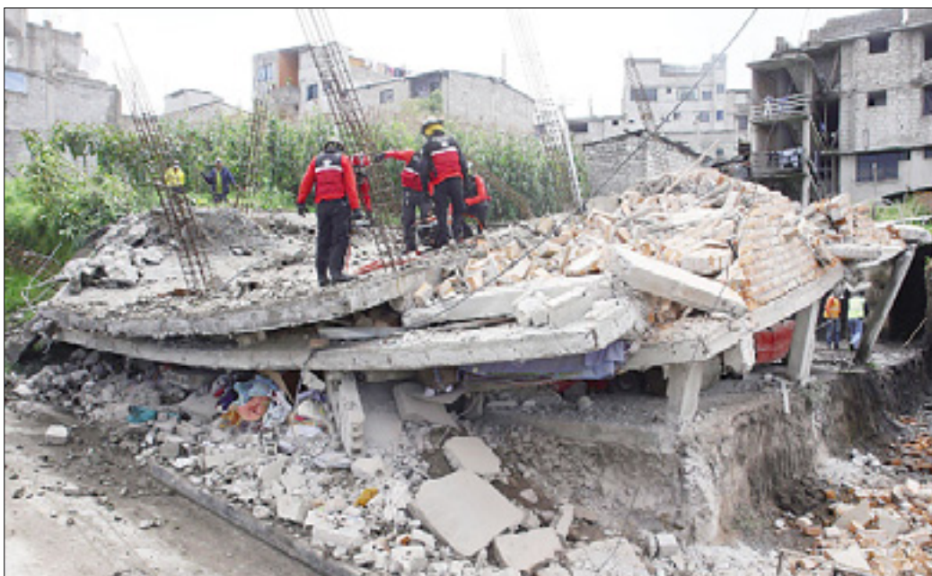
Potres je zrušil tudi nekatere železobetonske zgradbe
