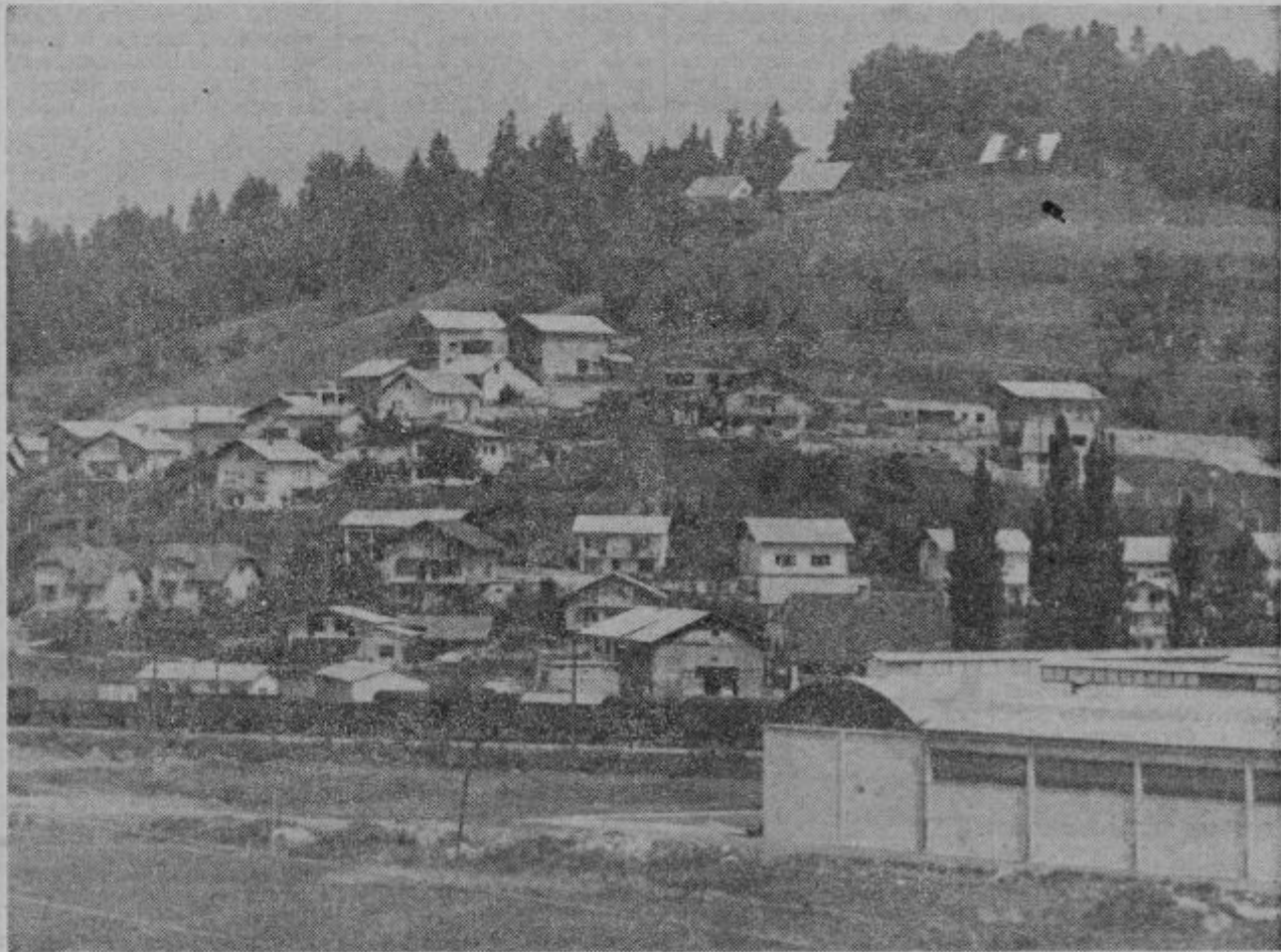
Ob občinskem prazniku v Šentjurju se Šentjurčani soočajo z mnogimi uspehi. Na sliki vidimo novo naselje v Šentjurju in del nove Alposove hale — cevarne. V njej bodo lahko dodatno zaposlili 50 novih delavcev. Nova hala obsega 10.000 m obdelovalne površine, v njej pa bo stekla proizvodnja, ki bo znašala letno 50.000 ton različnih železnih profilov. Danes v njej že pojejo stroji, čeprav bo poskusna proizvodnja stekla šele konec meseca.
