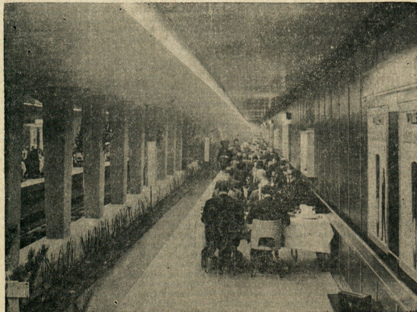
PODZEMNA RESTAVRACIJA — V Rotterdamu na Holandskem grade nov del podzemne železnice. Na kraju, ki je določen za postajo, so uredili začasno restavracijo za osobe, ki je zaposleno pri gradnji. Restavracija bo seveda izginila, ko bo prostor izročen svojemu namenu.
