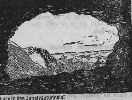
Der Durchbruch des Jungfrautunnels.
