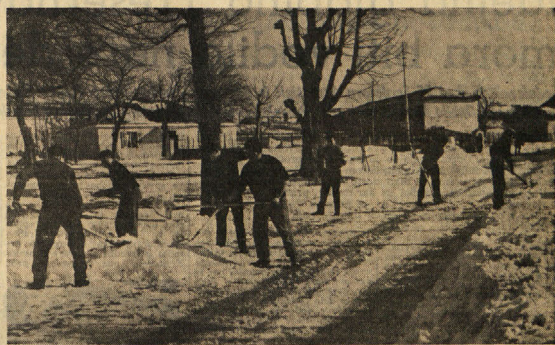
Pokrajinska uprava, ki skrbi za številne ceste tržaškega področja, ni bila pripravljena na letošnjo zimo s obilico snega. Posledica je bila, da so bile nekatere važne ceste za dva ali celo tri dni neuporabne, kar velja še posebno za cesto Bazovica — Trebše. Sele po treh dneh so začeli delavci čistiti cestne zametov, vendar bi bilo delo mnogo hitreje opravljeno, če bi imeli na razpolago snežni plug
