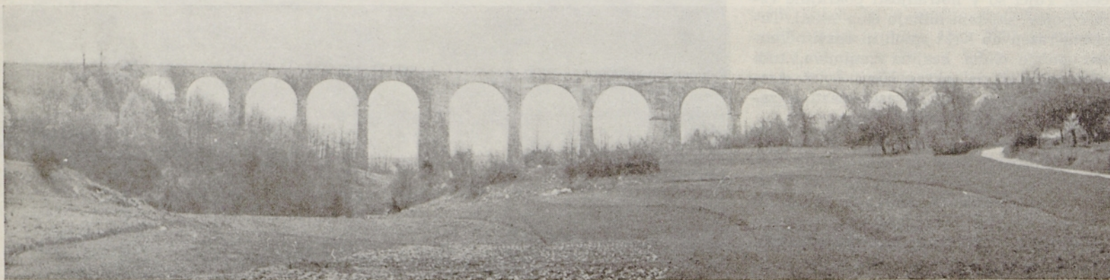
Viadukt pri Otovcu
