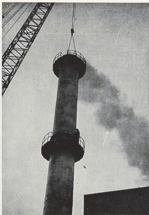
Drugi segment je uvrščen. Zaradi preizkušanja kotla je bil dimnik »krščen« že na višini 30 m
