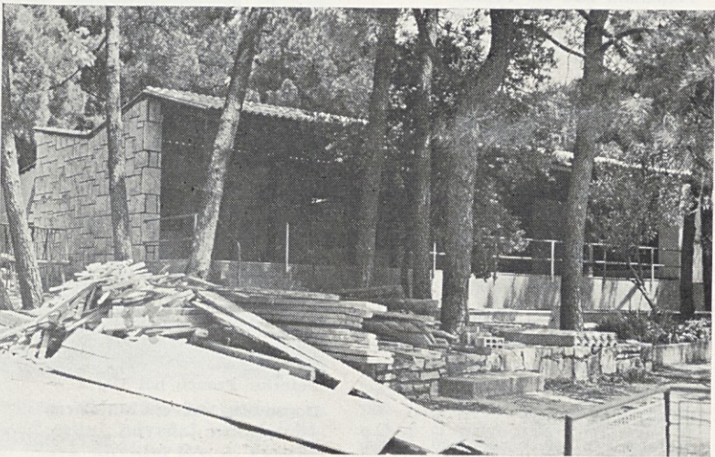
Gradnja podaljška terase. Za vse je zdaj dovolj prostora
