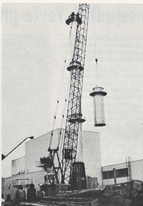
Začetek dviganja četrtega segmenta — višina 42 m. Gledalcev nikdar ni manjkalo
