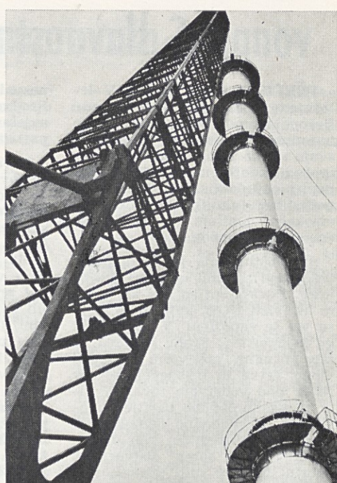
Dimnik je »zrasel« do višine 58 m. Sledila je faza glavne kontrole ravnosti in centričnosti dimnika
