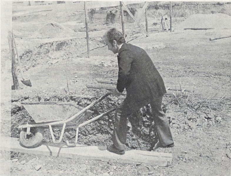
Direktor OZD Zdrženih papirnic Ljubljana—Vevče tov. Albin Vengust je pripeljal prvo samokolnico betona za ugraditev temeljnega kamna za zgradbo V. PS (5. junija 1975)
