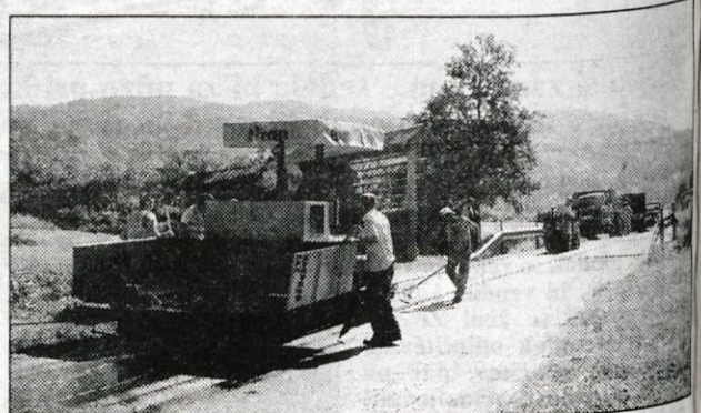
Vzdrževalna dela na eni od bohinjskih cest.
