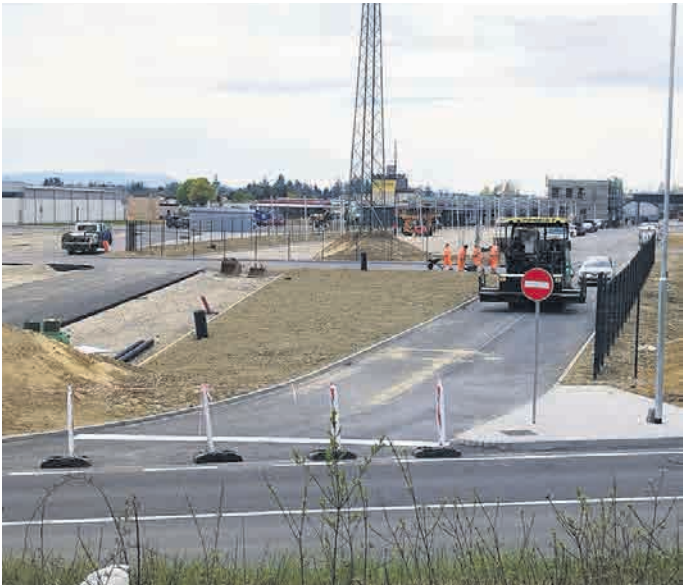
To je problematičen priključek na ormoško obvoznico.
