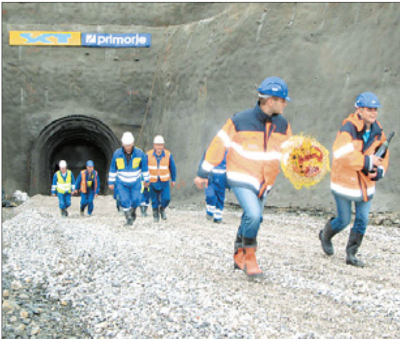
Včerajšnja slovesnost ob preboju dovodnega tunela
