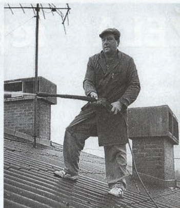
Mojster na visoki strehi izpira z vodo golobje ostanke s strehe in cevi.
