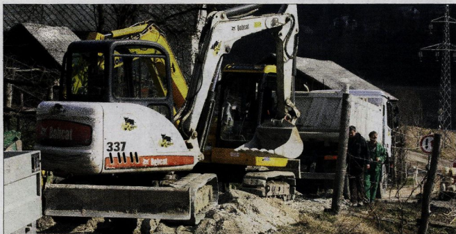
Cesta v Debru je odločno preozka, da bi si ob gradnji kanalizacije na njej lahko privoščili polovično zaporo.
