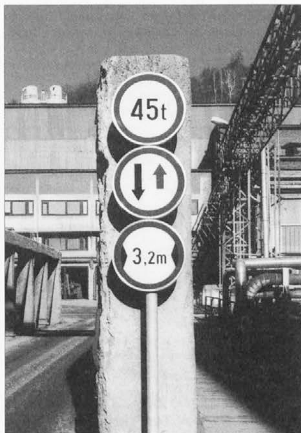
Novi prometni znaki na mostu pred Petrol Energetiko.
