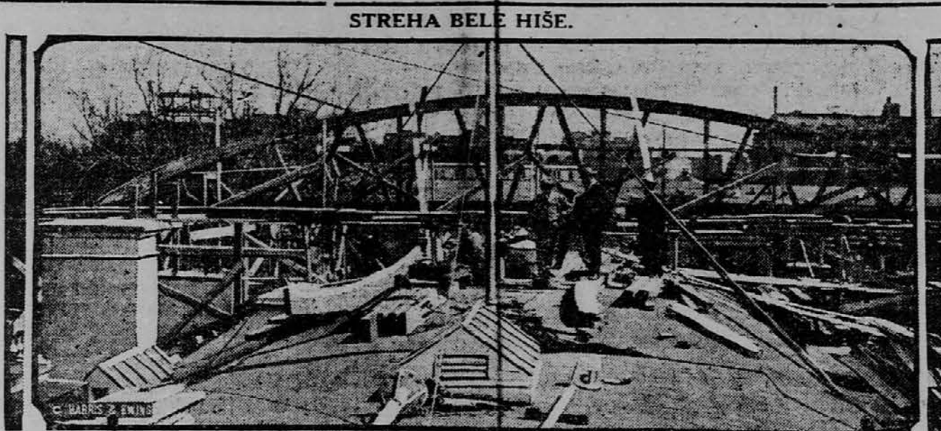
Na sliki vidimo streho Bele hiše, ki pa je že tako slaba, da jo bo treba nadomestiti z novo. Čim se predsednik Coolidge vrne s počitnic, bo nova streha gotova.
