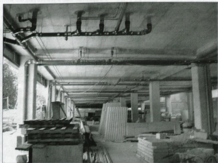
Ko so dela na višku - montaža razvodov za kanalizacijo.
