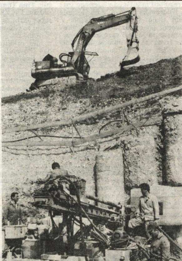
Zahtevna začetna dela v Karavanah — Delavci Geološkega zavoda iz Ljubljane sodelujejo pri najzahtevnejših začetnih delih za gradnjo predora skozi Karavanke. Skupaj z delavci Slovenijaceste bodo delali vse poletje, ker naj bi že avgusta začeli z vrtnalnimi stroji vrtati prvo cev predora. — Foto: F. Perdan
