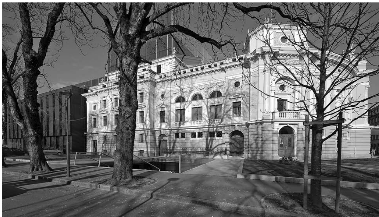
Prenovljena stavba SNG Opera in balet Ljubljana z jugovzhoda, 2011
