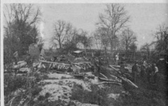
Preteklo soboto so se gasilci iz Zabovca množično udeležili akcije rušenja doma. Leseno ostrešje so že zložili ob dosedanjem domu, ki je za njih premajhen.
