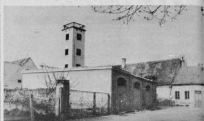
Stari gasilski dom v Ptuj je že brez strehe, v teh dneh pa rušijo tudi stranske stene. Vsa zidak je dragocen, pravijo gasilci iz Zabovca in Bukovca.
