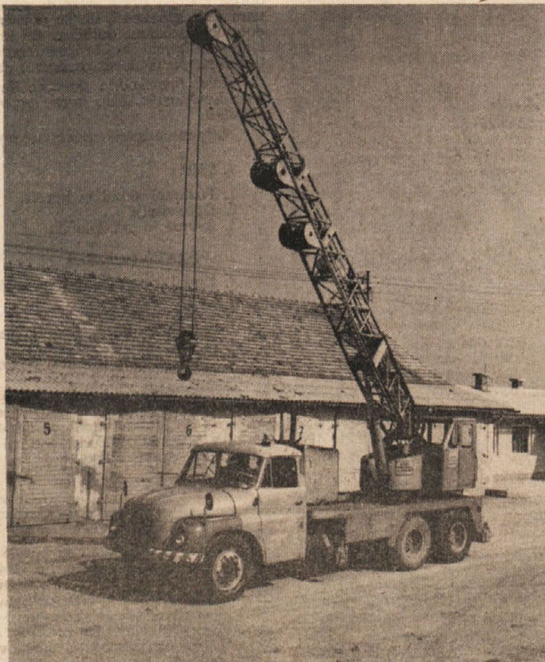
Avtodvigalo TATRA (H = 9 m, Q = 6 ton) je 7 let zvesto služilo pri vseh transportih in montažah
