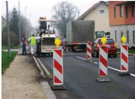
Preplastitev zaradi poškodbe cestišča
