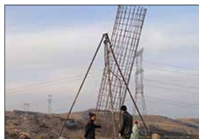
(d) Installation of reinforcement cage
