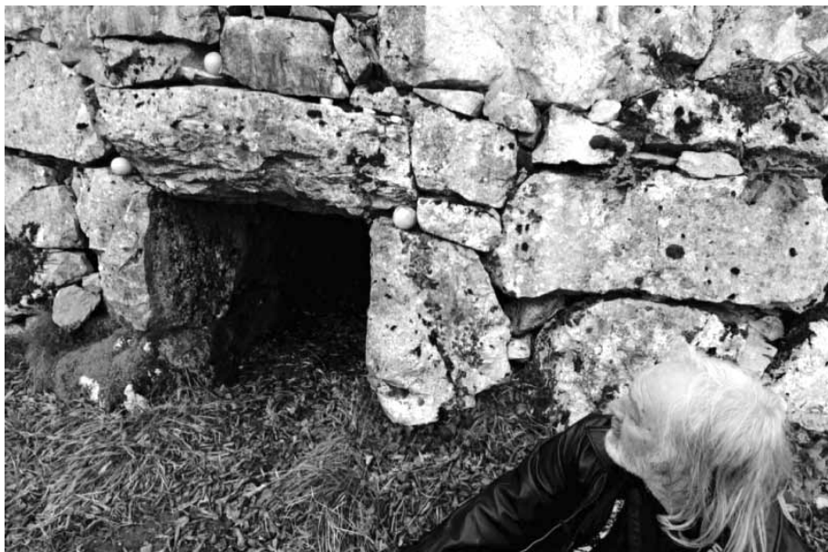
Slika 9: Bazovica, Italija, sveti vodnjak ob vasi. Doseg vode je umeščen v osrednji prostor, velik kak meter v krogu, prekrit s korbellingom velikih kamnov. Hodnik ali dostop do vode je delno klesan in delno korbelling, vhod pa je označen in zavarovan z velikimi kamni, ki dokazujejo pomen vodnjaka. Življenje starega verovanja pa zagotavlja preprosto krašenje.
