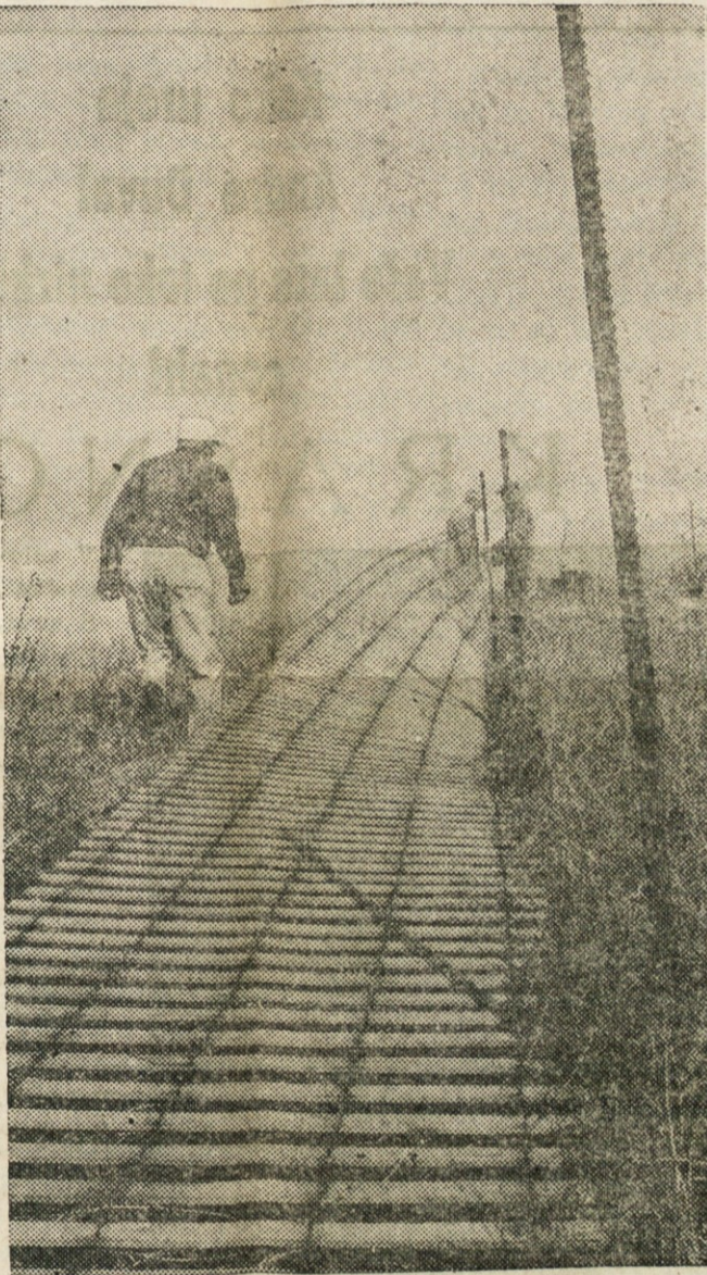
SNEŽNA OGRAJA JE VAŽNA — Snežne ograje varujejo po nekaterih predelih dežele domove in ceste pred snežnimi zameti. Na sliki vidimo postavljanje take snežne ograje preteklo jesen v New Glarusu v Wisconsinu.
