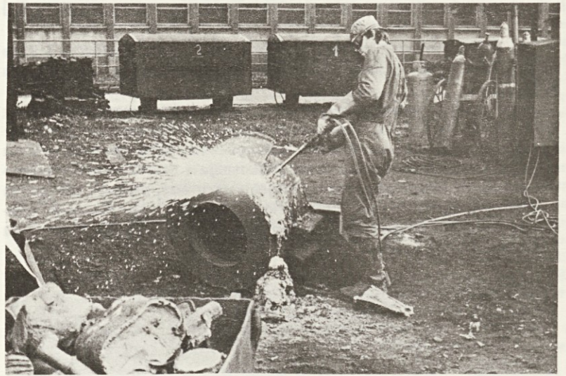
Na odlagalšču odlitkov sive in jeklene litine je opaziti veliko odlitkov, ki jih čistilci vneto pripravljajo za nadaljnjo proizvodnjo. Čistilci pravijo, da se že pozna, da deluje nova 30-tonska elektro peč, ki z večjo kapaciteto pripomore, da je iz dneva v dan več odlitkov.
