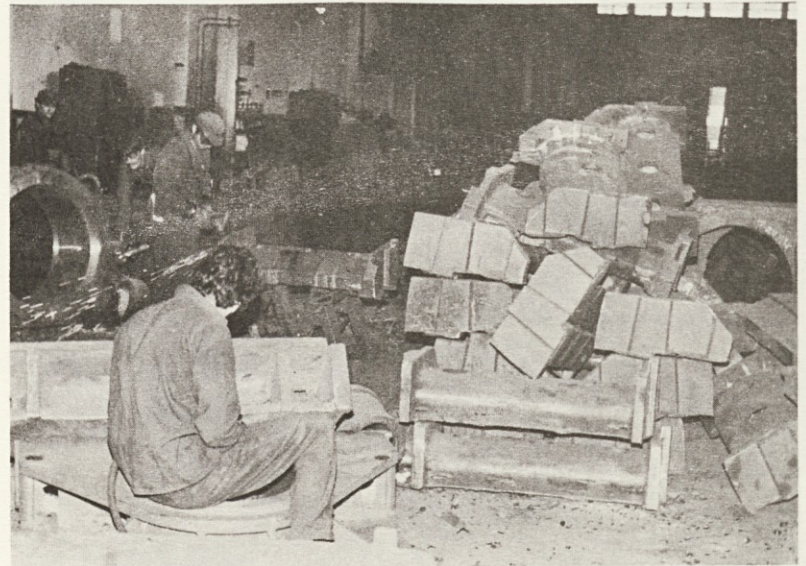
Na odlagalšču odlitkov sive in jeklene litine je opaziti veliko odlitkov, ki jih čistilci vneto pripravljajo za nadaljnjo proizvodnjo. Čistilci pravijo, da se že pozna, da deluje nova 30-tonska elektro peč, ki z večjo kapaciteto pripomore, da je iz dneva v dan več odlitkov.
