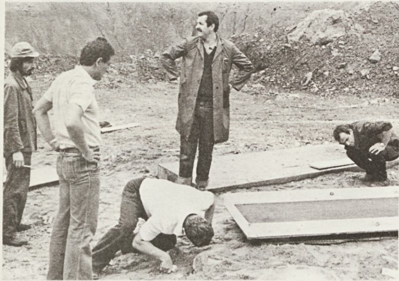
Zadnje preverjanje postavitve osnovne in naležne plošče, medtem ko direktor Tomeksa dipl. ing. Katana nadzira pripravo eksploziva
