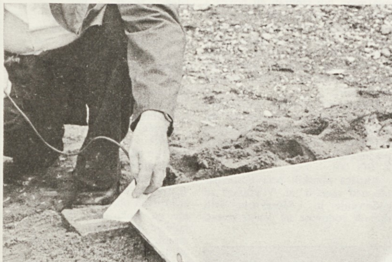
Nameščanje detonatorja in zažigalne vrvice. Delovna ekipa se je že umaknila na varno
