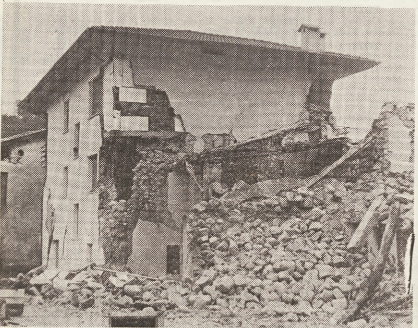
Značilno rušenje hiše v Teru pri kateri je bilo ob gradnji več poudarka na izolaciji kot nosilnosti
