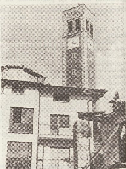
Novi cerkveni stolp, ki je ostal popolnoma nepoškodovan
