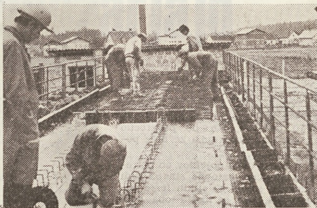
Betonski elementi za mostove »nastajajo« na nizko-grajskem zemljišču
