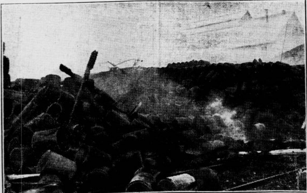
Ogromne skladownice pločevinastih bobnov, napolnjenih s karbidom, potem, ko se je zrušila streha skladišča št. 2
