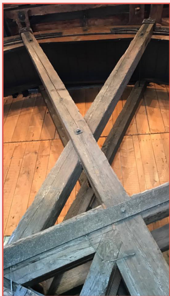
Kamšt je največje leseno kolo v Evropi, postavljeno v sedanji izvedbi okoli leta 1790 kot črpalna naprava za odvečno vodo v rudniku živega srebra (detajl kolesa).
