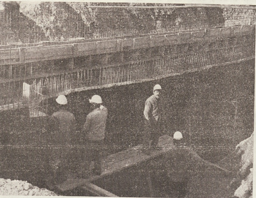
Se en posnetek z gradbišča na ljubljanskem bazenu na Ježici
