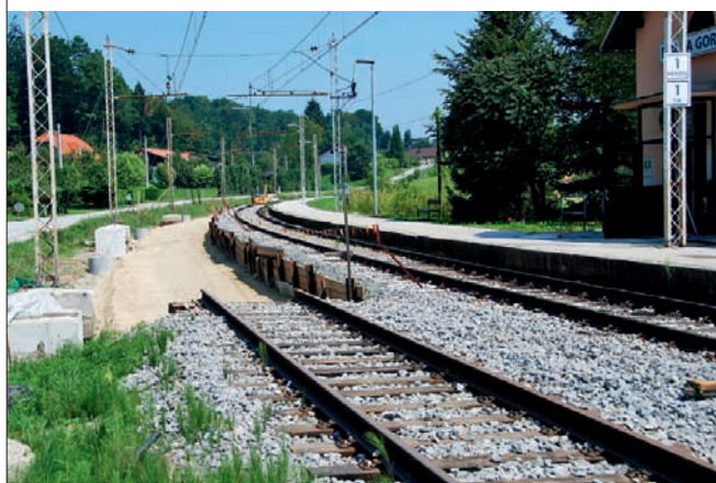
Z omenjenimi ukrepi bo dosežen dvig kategorije iz C3 (20 t/os in 72 kN/m) na D4 (22,5 t/os in 80 kN/m)
