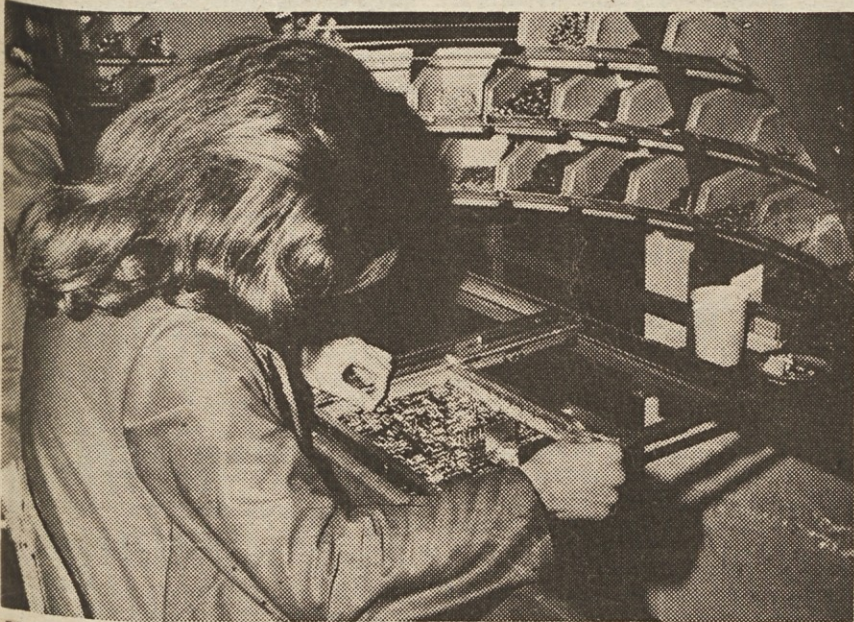
Vlaganje elementov v tiskano vezje novega črno-belega televizorja v polvodniški tehniki.
