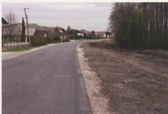
... v Mali vasi pa poteka modernizacija ceste.
