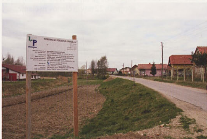
Na Forminu je v gradnji kanalizacija ...
