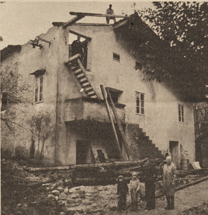
To je bila hiša naše delavke iz bovške temeljne organizacije združenega dela, ki so jo porušili zaradi usodnih razpok, ki so jih povzročili potresni sunki.
