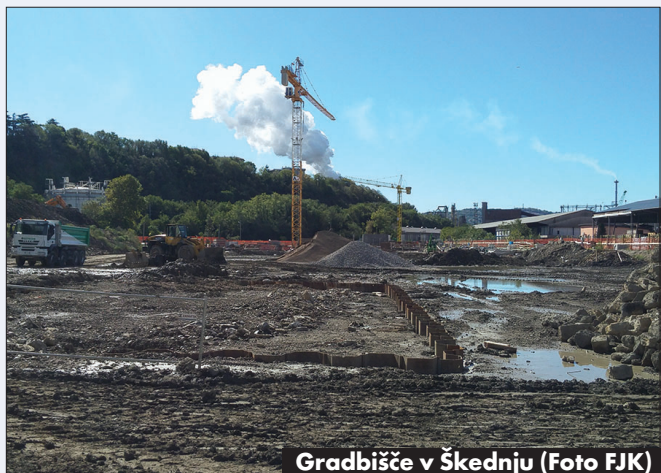
Gradbišče v Škednju (Foto FJK)
