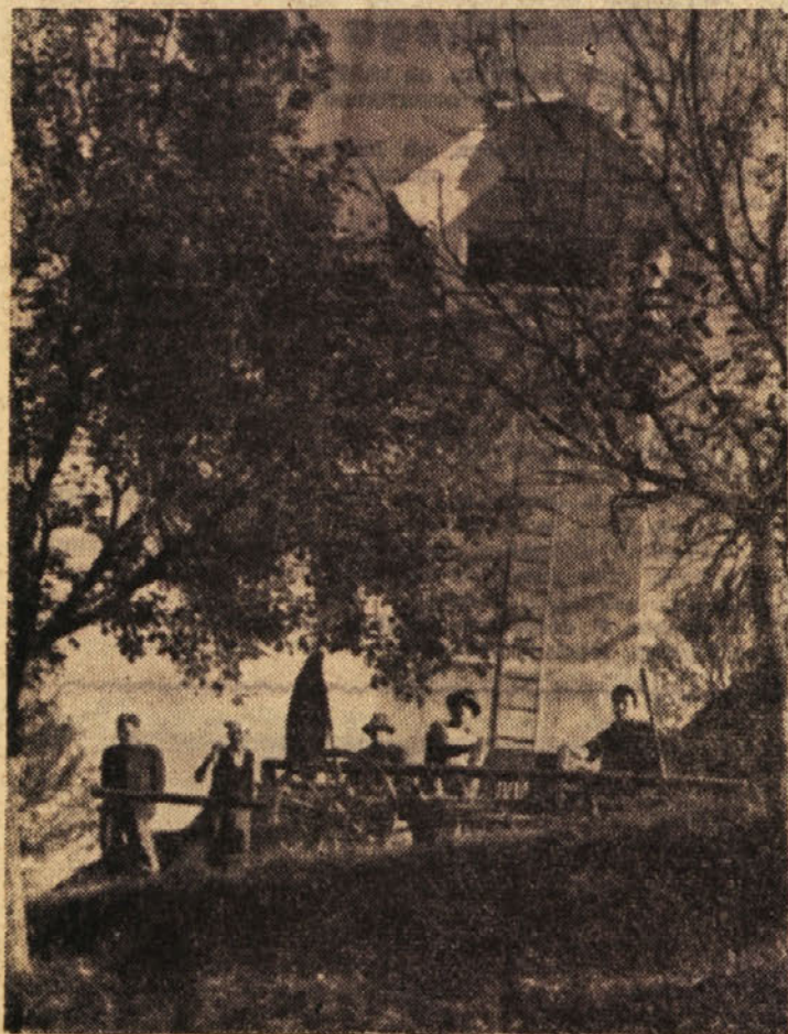
Transformator na Malkovcu. Naš dopisnik je zvedel, da so vaščani pri gradnji pridno pomagali
