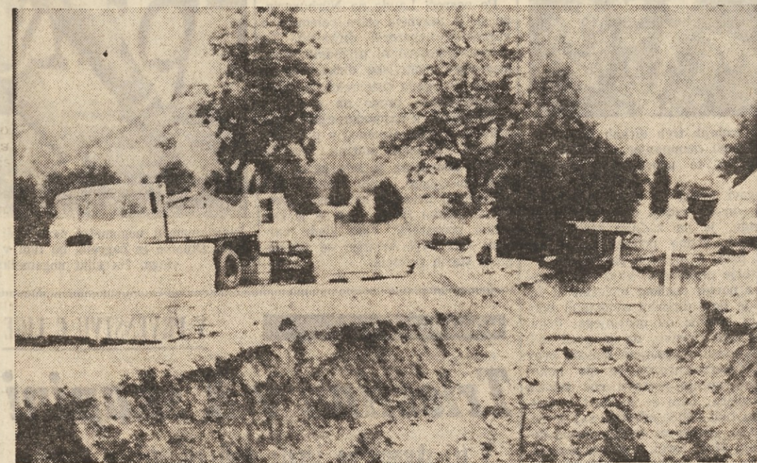
Priprave za gradnjo naselja »Lario« pri Osojanah.
