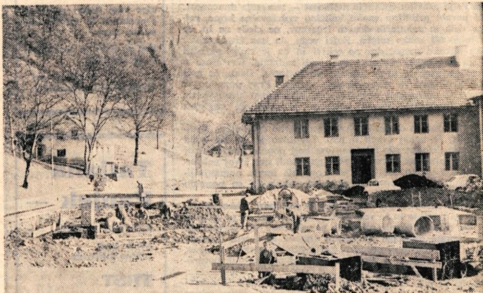
Na Češnjici v Selški dolini gradi Petrol novo bencinsko črpalko, ki bo v primeru lepega vremena končana do dneva republike, 29. novembra. Izvajalec gradbenih del je SGP Tehnik iz Skofje Loke. — Foto: F. Perdan
