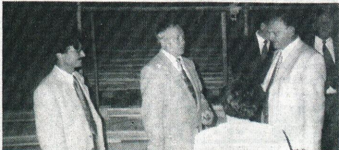
Minister si je ogledal gradbišče Kulturnega doma in v razgovoru z g. Matjažem Karlovškom, glavnim projektantom, in g. Andrejem Girandonom, nadzornikom obnove, zvedel marsikaj zanimivega.
