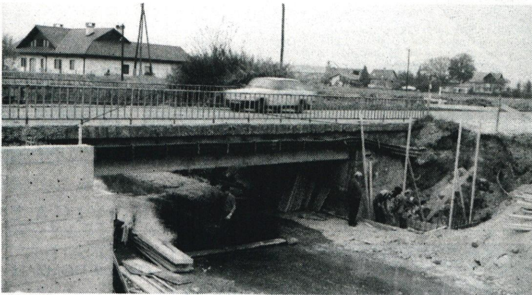
Gradnja mostu za pešce čez prekop Pšate v Jaršah
