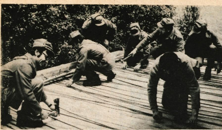
Udeleženci vojaške vaje iz zgornjega dela Gorenjske so vsak trenutek prostega časa izkoristili za pomoč na Pučevi domačiji. Pomagali so pri gradnji betonske plošče nad novo delavnico...
