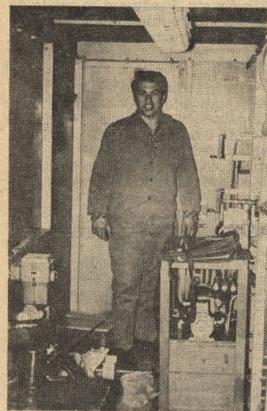
Montaža merilne regulacije za fider E banje
