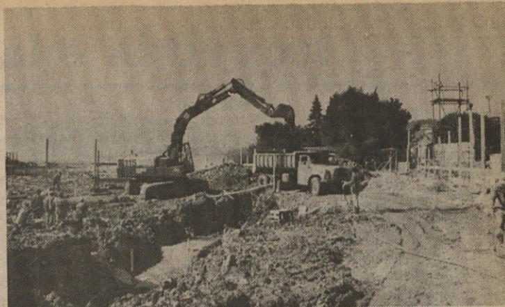
Zemeljska dela na gradbišču v Portorožu.
