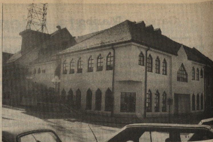
Pošta na Ravnah je že končana. Računajo, da jo bodo odprli maja, novo telefonsko centralo pa naj bi montirali oktobra.
