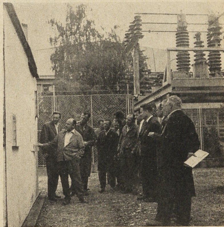
Zvone Tepina: Nova transformatorska postaja je plod skupnih prizadevanj
