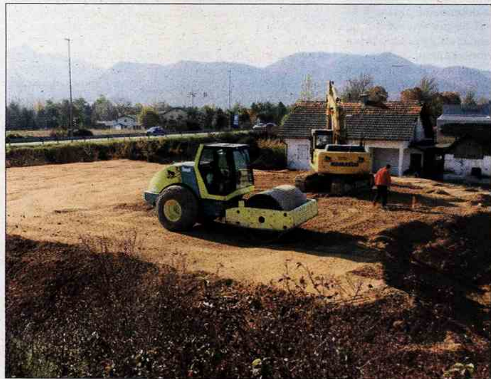
Gradnja petkakega krožnega križišča v Dobrteši vasi se je začela.
