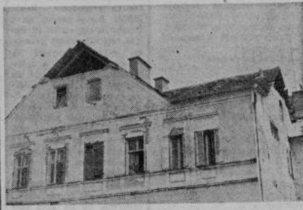
Solo v Zibiki bodo podrti, na njeno mesto pa bo prišla Marlesova montažna zgradba.
