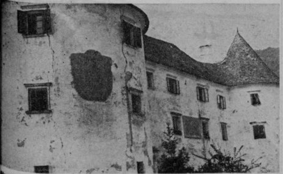
Šole in dolge so brazgotine, ki jih je potres prizadel olmskemu gradu. V ospredju Marlesova montažna zgradba.
