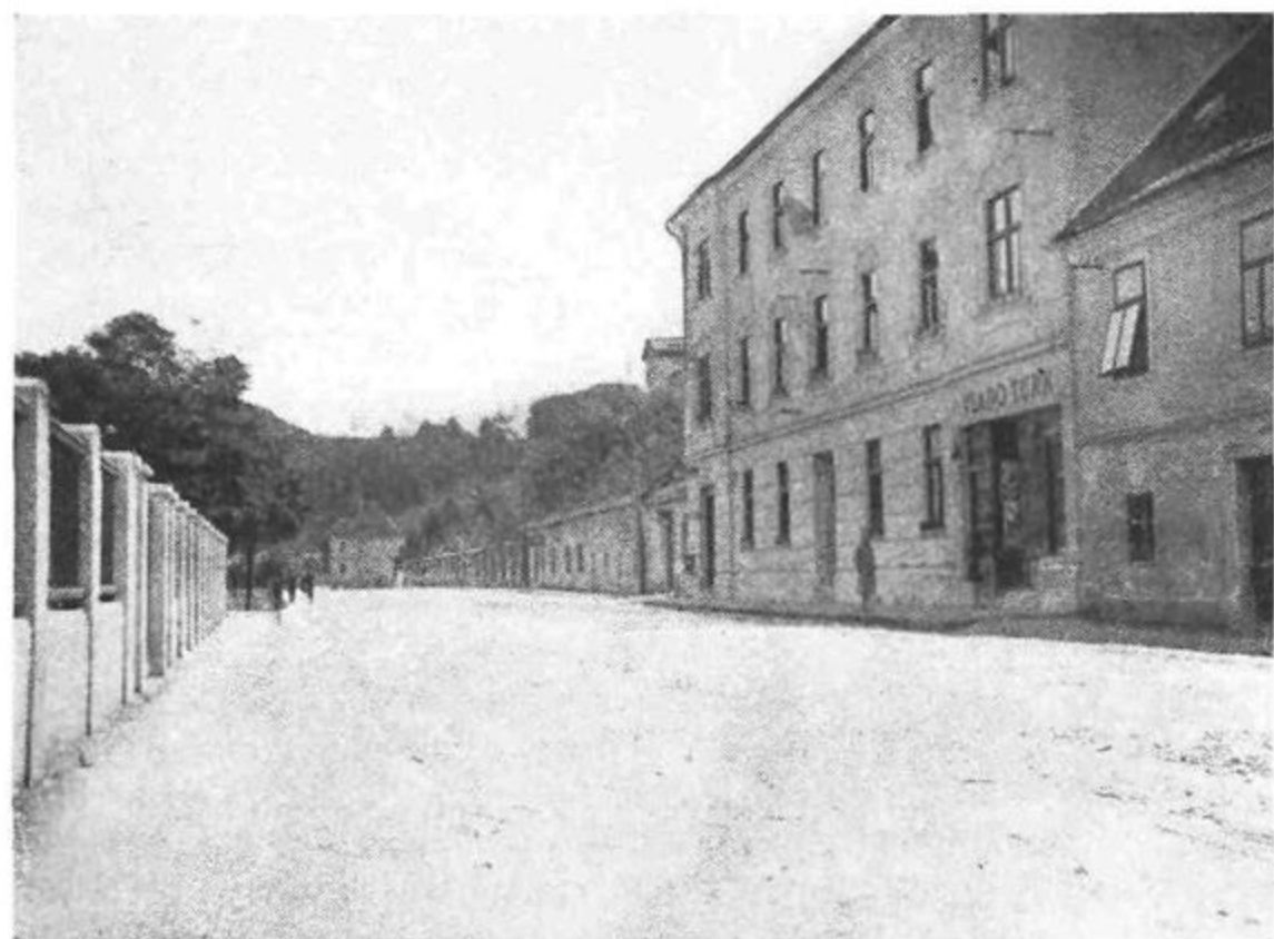
Položaj pred 1931: Pritlično poslopje na levi poleg nove dvonadstropne hiše je nekdanja Pinhakova vitriolna tvornica
